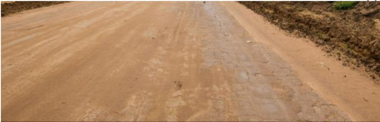
Figure 8-7: Restes d'asphalte sur la route entre Boma et Muanda
